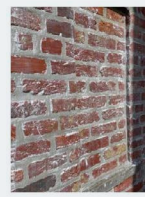
vers aangebracht op gevelmetselwerk
