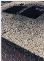
Verwijderen van roetaanslag en brandschade
