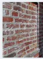
vers aangebracht op gevelmetselwerk
