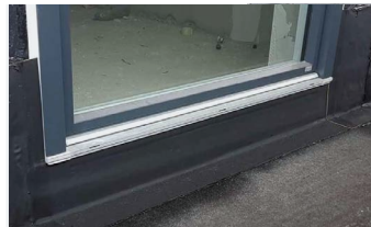
Afdichten van raam- en gevelverbindingen
